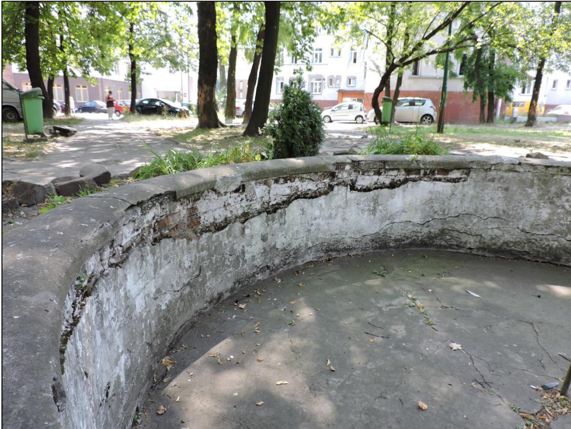
Fot. 24 „Wiktoria rzucają wieniec” – widok wymurowanego z cegły i otynkowanego otoku fontanny, stan zachowania z sierpnia 2015 r.
